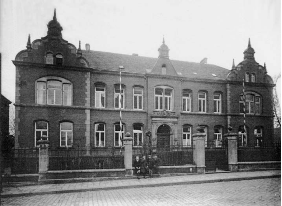
Erstes Schulgebäude des heutigen Ratsgymnasiums (Foto von 1908)
